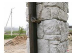
По окончании выставления столбовых блоков, установить оголовники (крышки) на столбы. Оголовники столбов рекомендуется монтировать на следующий день после окончания монтажа блоков. Монтаж оголовников осуществляется на клей без разрывов, для исключения попадания в будущем влаги внутрь столбов. В полых закладных (трубах) под столбы не должна скапливаться вода. Они должны быть сверху закрыты заглушками.
