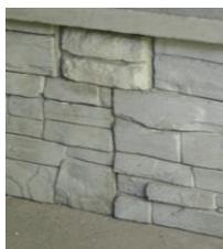
Блоки перегородок «кирпич-рустик» и «булыжник» переворачивать нельзя, т.к. у них с верхней стороны имеется имитация расшивки. Блоки перегородок «камень-валун» и «скальная гряда» имеют длинный и короткий выступ для монтажа вставки.
